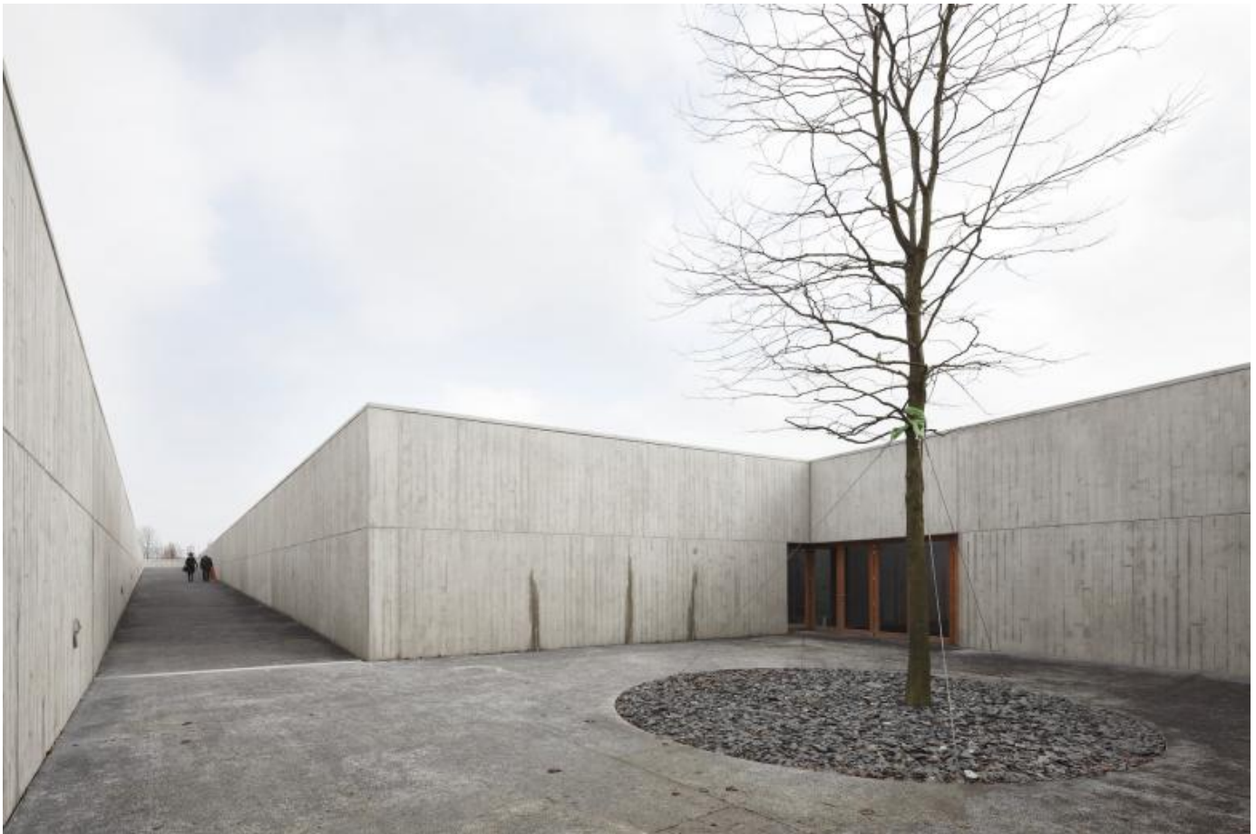
Uitzicht Crematorium in Kortrijk by Eduardo Souto de Moura and SumProject (Photo: Stijn Bollaert)
