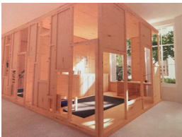
Akoestische isolatie d.m.v. houten constructie met glazen wanden
