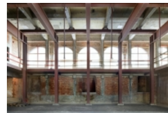
Umbau des Rathauses in Mortsel von Eagles of Architecture (bis 2024)
