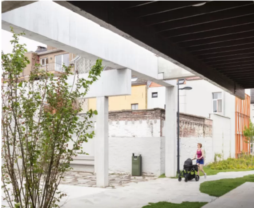
Standaertsite Gent, ontworpen door ae, Carton123 en murmuur architecten. Beeld Michiel de Cleene
