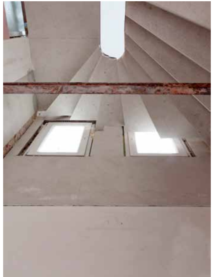
Ter plaatsen gestorte betontrap
