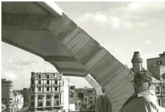
Architect Léon Stynen op de bouwplaats van het Kursaal, op het terras aan de westzijde, vermoedelijk 1951.(foto VAi, Collectie Vlaamse Gemeenschap, Archief Léon Stynen)
