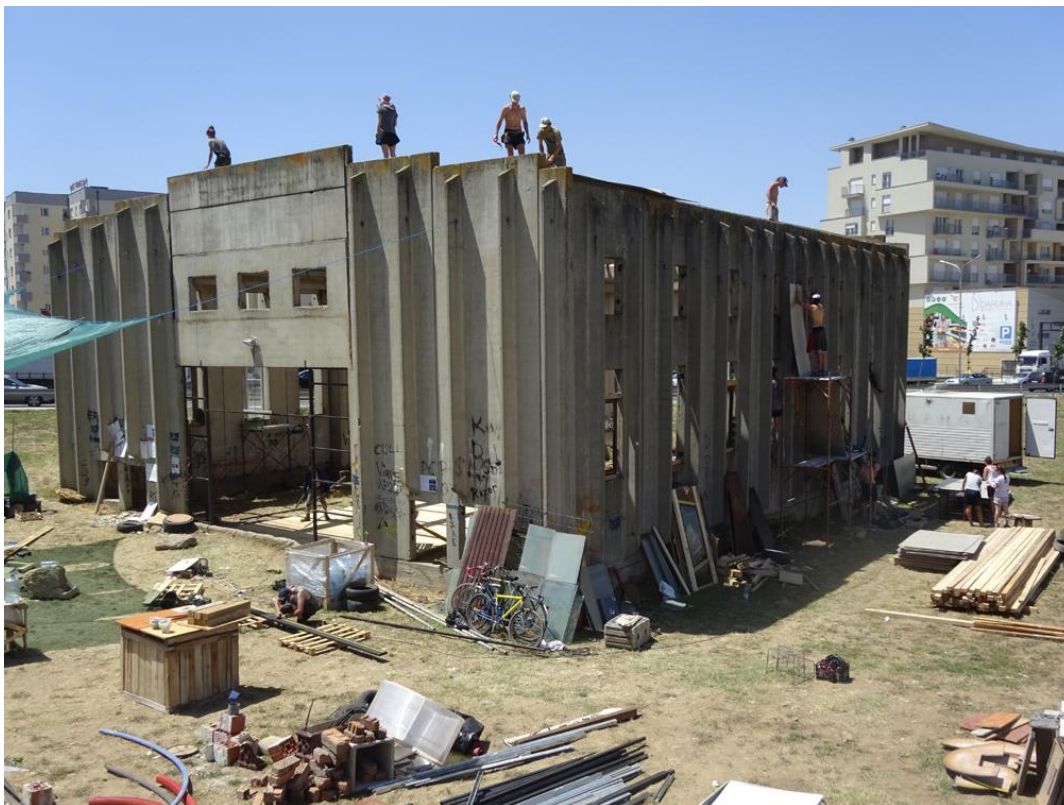
Transformatie van een leegstaand gebouw in Prishtina (Kosovo) tot een ruimte voor de gemeenschap, een samenwerking tussen Toestand (BE), InfoQuartier Mâche (CH) & Prishtina Architecture Week (KS)
