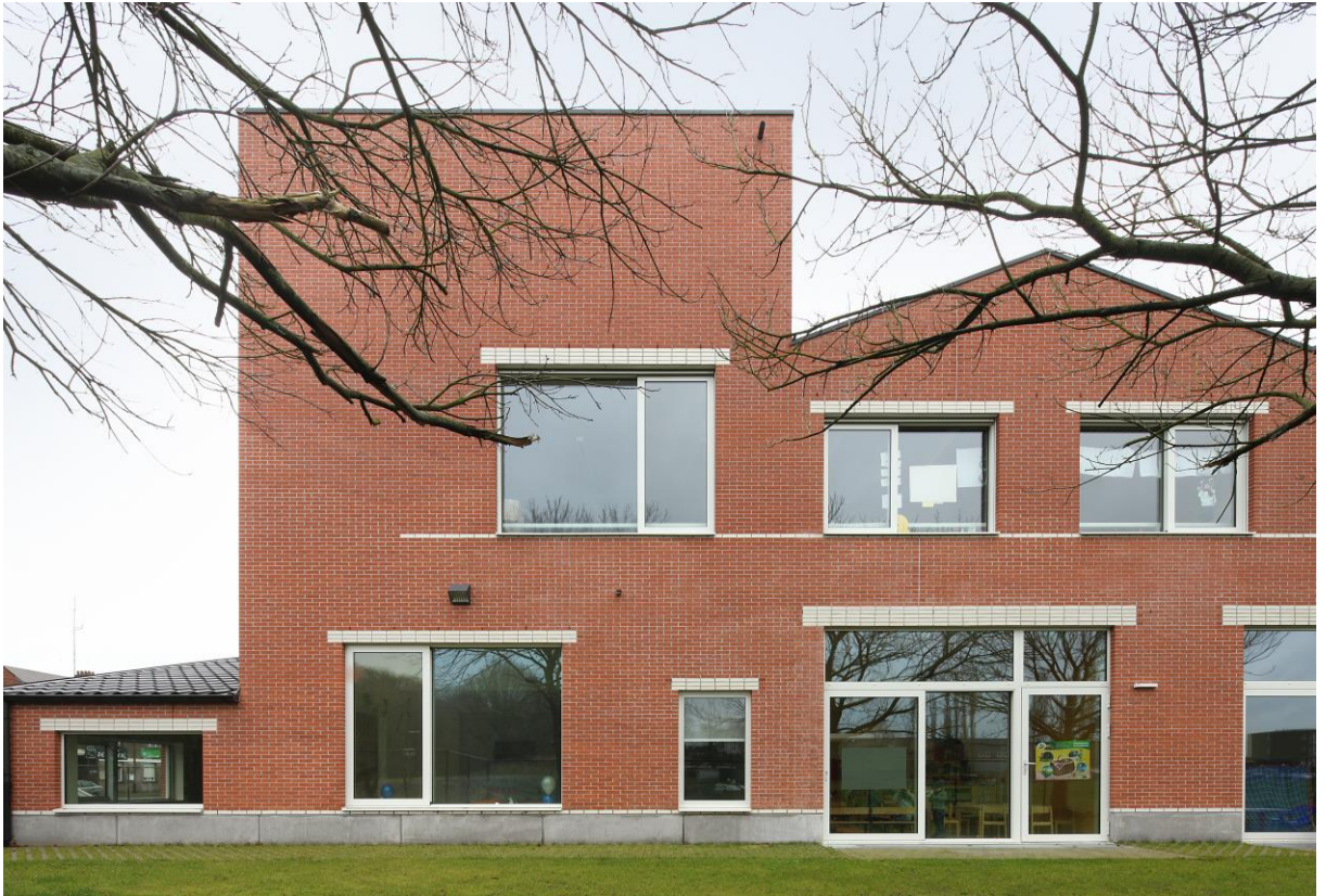
School, Berlaar, Bovenbouw Architectuur © Filip Dujardin
